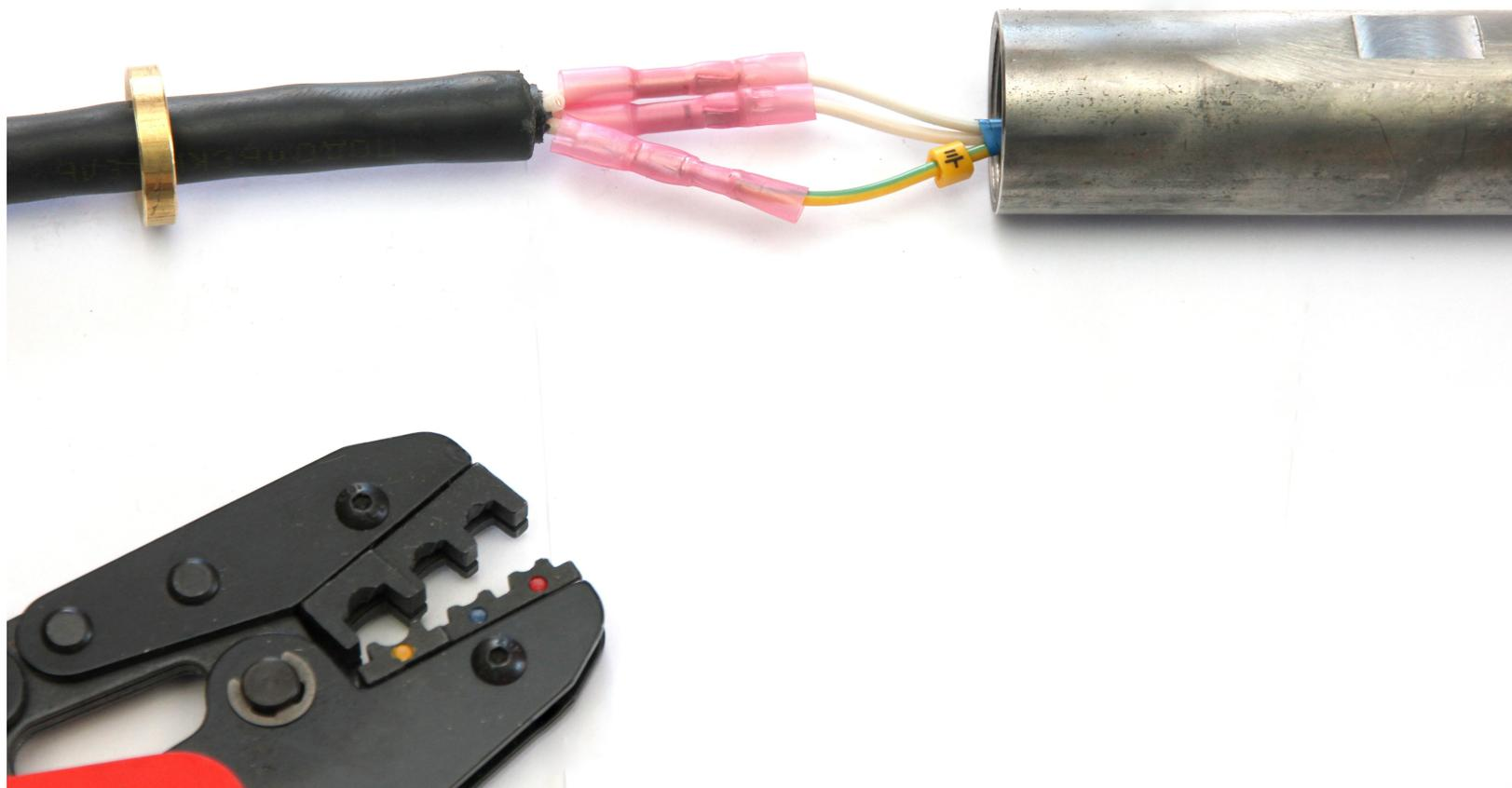
Шаг 7. Аккуратно надвинуть клеммный отсек сигнализатора на соединение кабелей, при необходимости слегка поворачивая корпус сигнализатора
